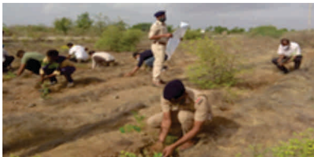
GMDC Umarsar Lignite Mine
